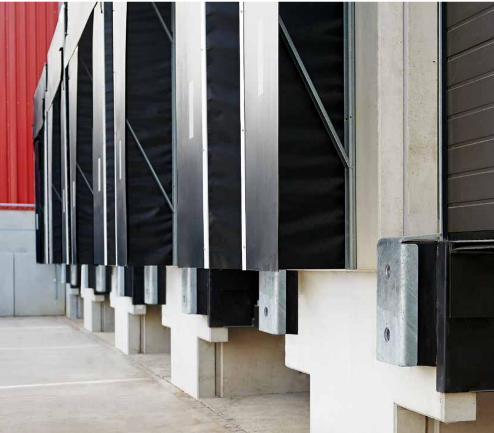
Los topes de goma protegen la rampa y el edificio de daños importantes. Absorben las fuerzas dinámicas del camión durante el proceso de carga. Por este motivo deben ser estables pero a la vez flexibles. En función de las exigencias están a disposición diferentes placas y consolas de montaje.
