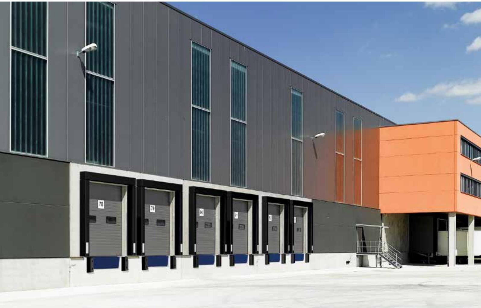
Para aquellos casos en los que acoplen vehículos de medidas similares, con la misma estructura y sin registro superior, se recomiendan los abrigos de muelle de espuma para una estanqueización óptima.
